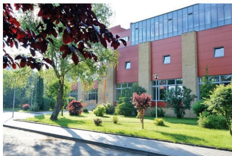
Ilustracja 5. Budynek Biblioteki Politechniki Śląskiej
