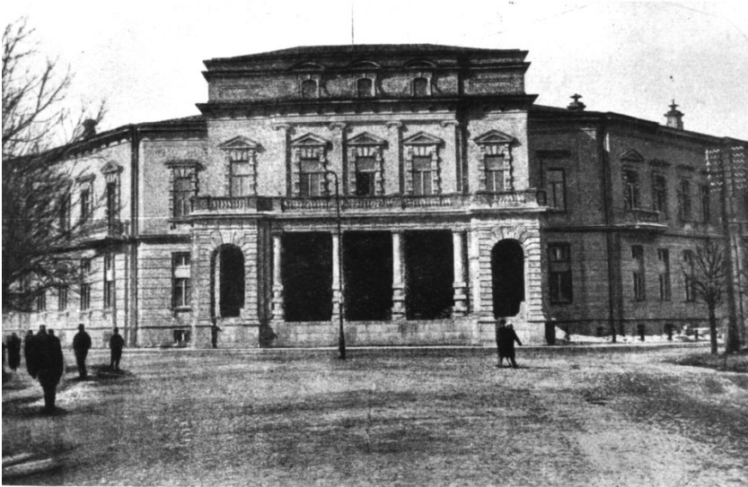
Fot. 1. Biblioteka im. Wróblewskich. Widok ogólny
